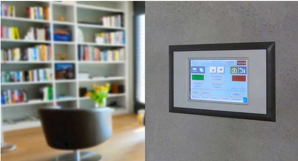
Ein Touchpanel erlaubt komfortables Wählen von Lichtstimmungen, Temperatursollwerten, Storenfunktionen und zeigt beim Verlassen des Hauses an, ob alles im richtigen Zustand ist.
