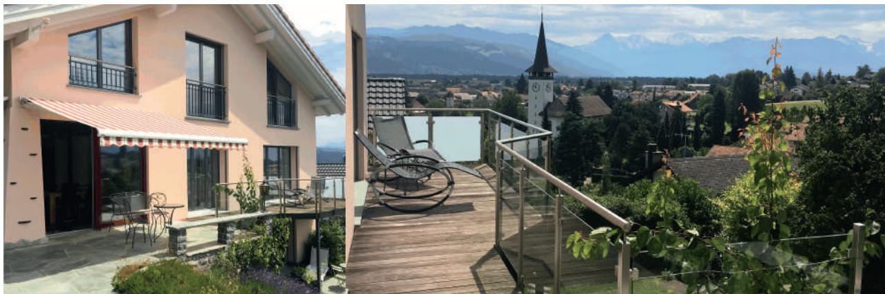
Im privaten Wohnhaus geniesst der Inhaber der Elektro Gertsch AG die Aussicht aufs Berner Oberland. Seit dem Umbau steuert das Gebäudeautomations-system NOXnet die elektrischen Verbraucher.
