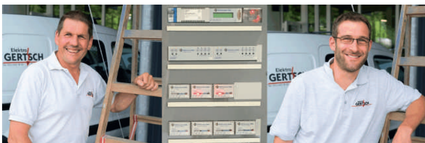
Jürg Gertsch und Martin Wenger bei der Verteilung im OG. In einem zweiten Tableau ist die Aktorik fürs UG untergebracht.
