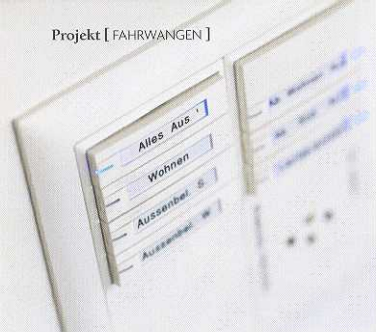
Beleuchtung, Beschattung und Beschallung aus der Musikanlage lassen sich an zentral angeordneten Tastern steuern.
